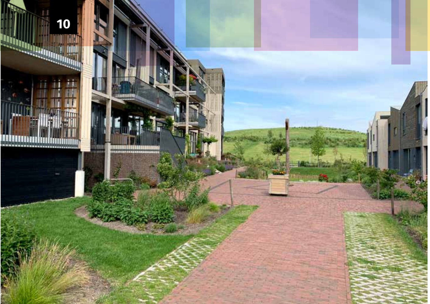
Zicht op appartementen en eengezinswoningen Almansweide
